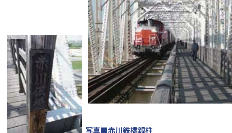
写真■赤川鉄橋
